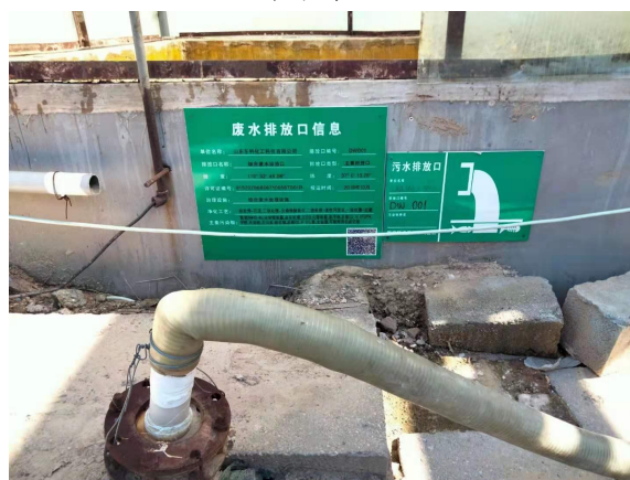
综合废水排放口
