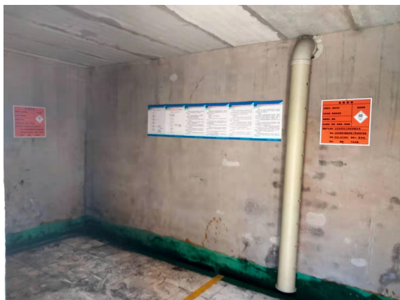
危废暂存间（外）
